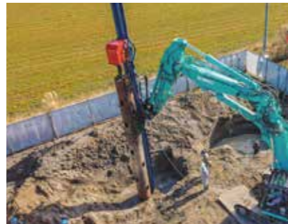
杭抜き作業風景
