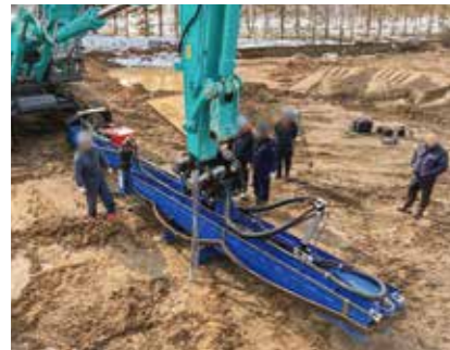
組立作業風景
