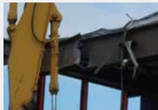
③切断完了
