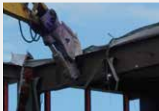
①ウェブ穴開け、上部フランジ切断
