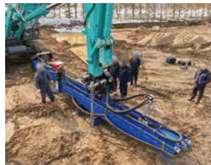
組立作業風景
