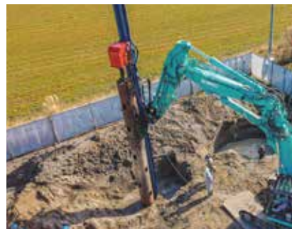
杭抜き作業風景
